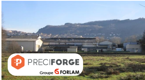
Usine de métallurgie à Thiers (63)
